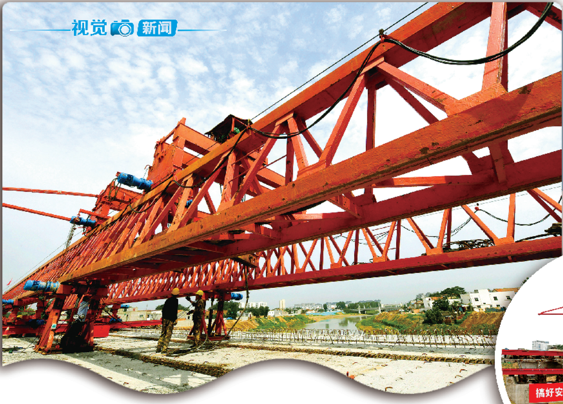
6月11日上午，周口中心城区文昌大道西延工程中的跨贾鲁河二板交通桥第四拱桥箱吊装完毕，意味着经过8个多月施工，二板交通桥即将合龙。据了解，二板交通桥设计全长156米、宽30米，预计工期1年。 记者 梁照曾 摄
