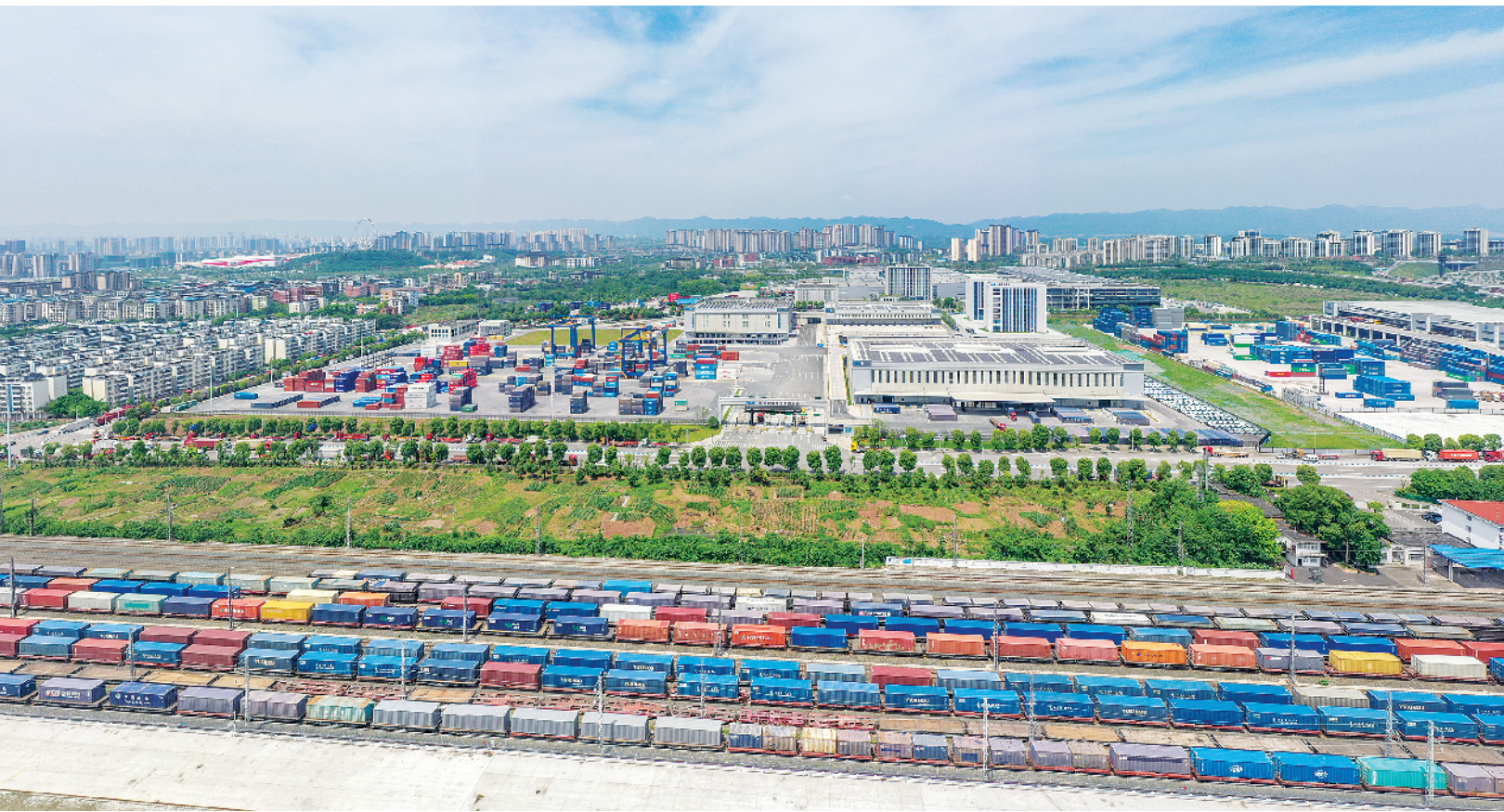
这是5月5日在重庆国际物流枢纽园区拍摄的兴隆场编组站和陆海新通道重庆无水港(无人机照片)。随着货物运输量日益增长,位于重庆市沙坪坝区的重庆国际物流枢纽园区龙门吊起降不停、转运卡车来往穿梭……一片繁忙景象。重庆国际物流枢纽园区包含团结村中心站、西部陆海新通道重庆无水港、重庆铁路口岸等片区,是重庆中欧班列、西部陆海新通道班列等物流通道班列的主要到发点。新华社记者 黄伟 摄
