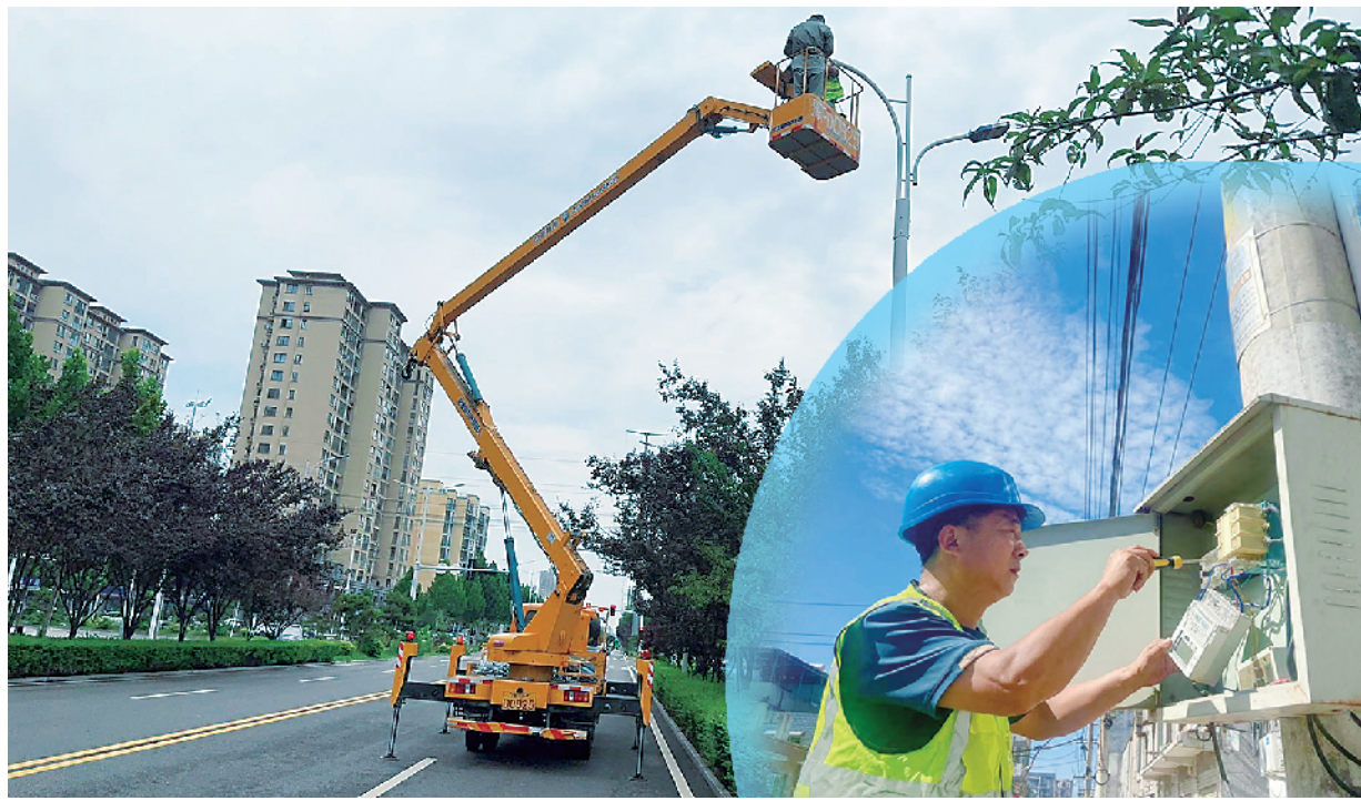
周松光正在顶着烈日维修路灯。
