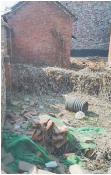
扶沟县城郊乡田庙行政村存在残垣断壁、散落建筑及生活垃圾、水体黑臭、水面漂浮生活垃圾、生活污水直排沟内等现象
