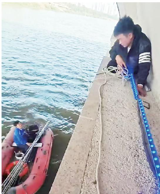
施工人员在桥墩上维修灯带线路。
